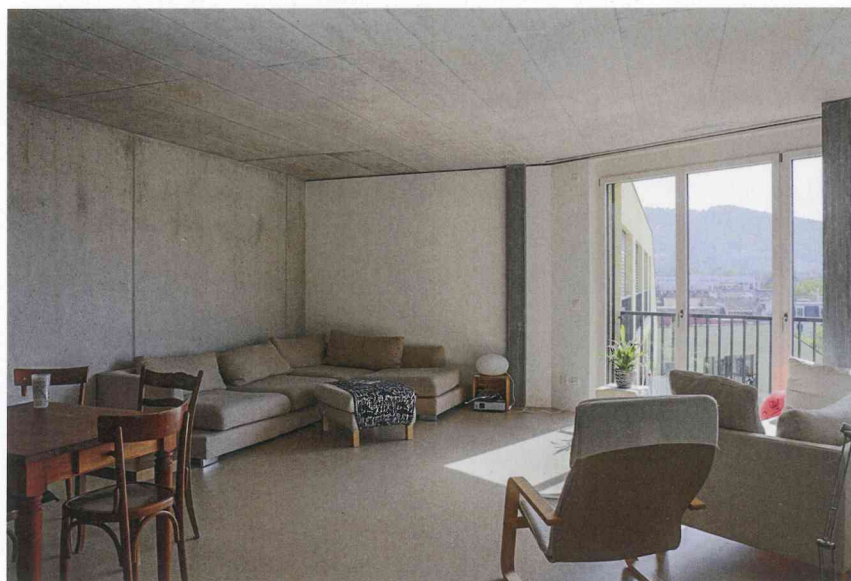
Skelettbauweise mit Sichtbetondecken: Blick in eine Wohnung.
